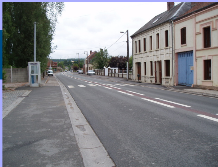
RD 901, voie d'accès à une gare TER à sécuriser par bandes cyclables
