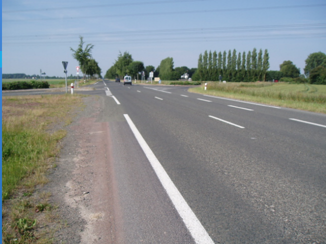
Ex RN 28 : besoin de bandes dérasées Multifonctionnelles + sécurisation intersections
