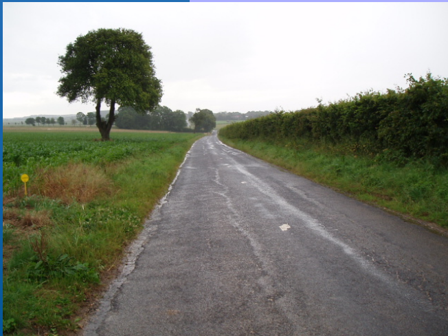
Route communale très peu circulée : jalonnement
