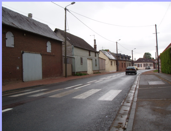
Traversée de village par route départementale (RD 11) à sécuriser par chaudiouces
