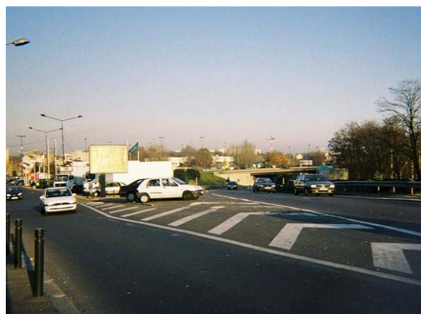
Echangeur de voies rapides de la Porte de Paris à Saint-Denis.
