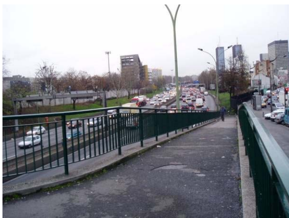
Franchissement du boulevard périphérique.
