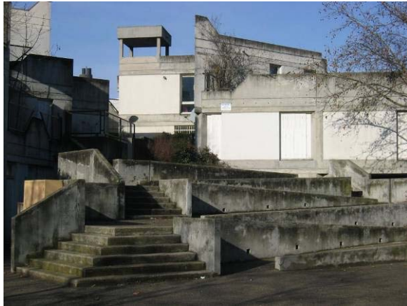
Accès aux terrasses depuis l'av du 8 mai 1945.
