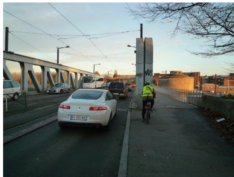
Valenciennes : Pont Jacob, trottoir autorisé aux cyclistes
