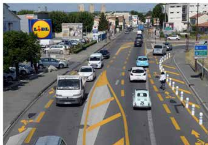
1 Bandes cyclables sur rte de Montfavet, créées par neutralisation d'une voie (mise en service 2020)
