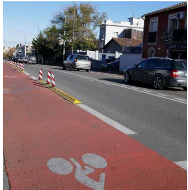
La bande cyclable existante a été renforcée par une piste cyclable renforcée par des balises et de la couleur.
