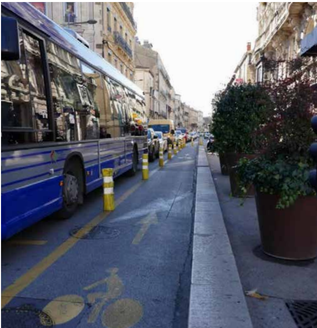
Double-sens cyclable sur l'avenue Georges Clémenceau protégé physiquement par des balises.
