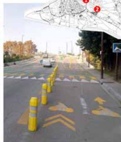
2 Pistes cyclables av Amandier, Créées par raccourcissement bretelle d'insertion (mise en service 2020)
