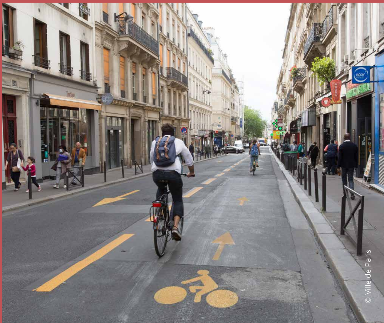
Vélorue de la rue d'Amsterdam à Paris : les sens interdits en tête-bêche permettent d'assurer un bon niveau de confort sur la ligne 13 du vélopolitain.
