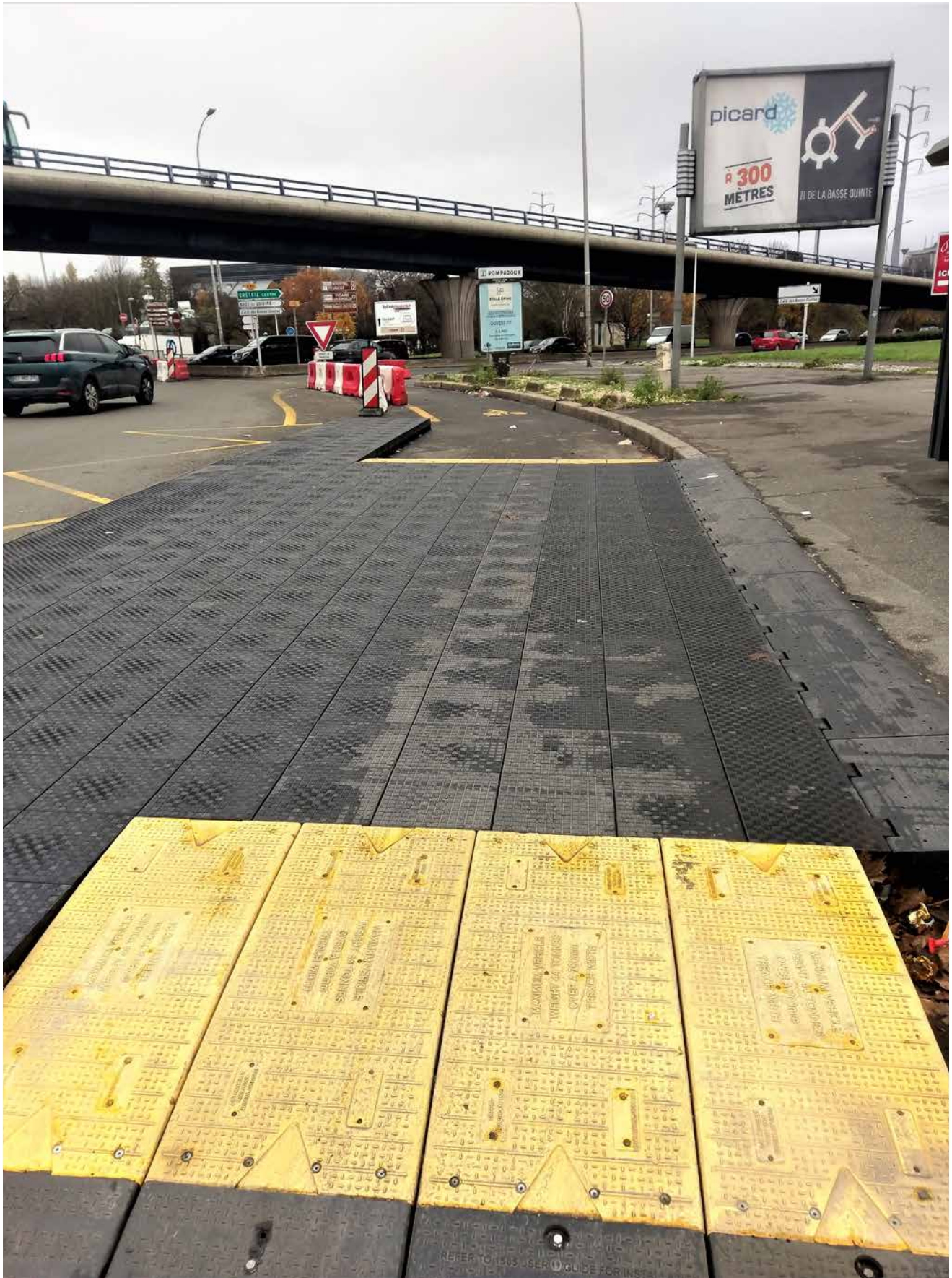
Aménagement cyclable transitoire sur le carrefour Pompadour avec implantation d'un quai bus déporté
