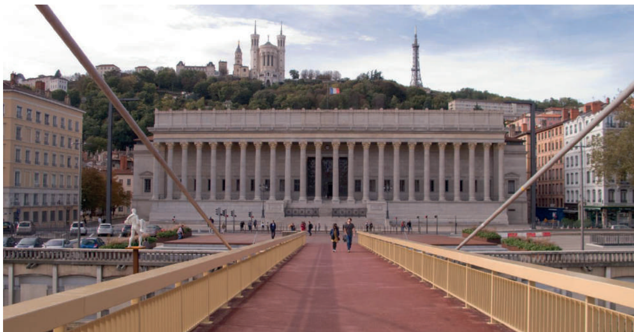
Passerelle piétonne du Palais de Justice de Lyon
