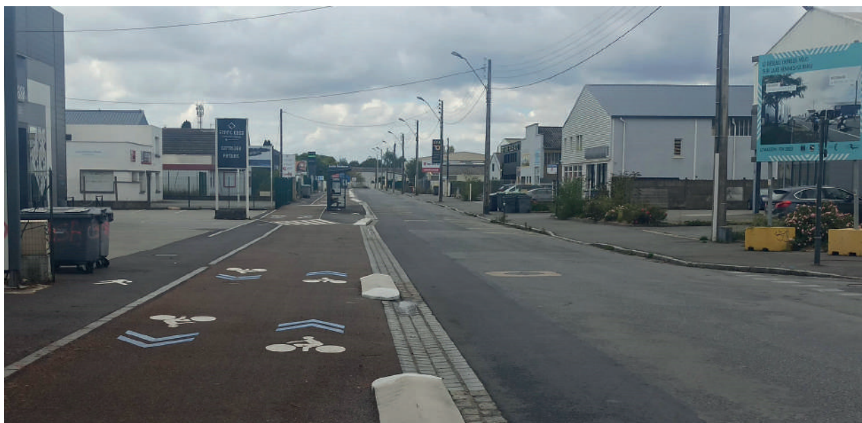
Aménagement d'un quai de bus aux abords d'une piste du réseau express vélo de Grenoble
