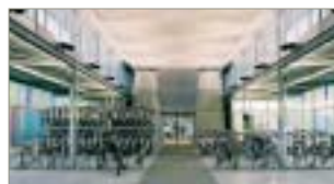
La vélostation dans les pôles d'échanges ou au droit des stations de RER, TER ou de tramway est la carte maîtresse de l'intermodalité. Ici la Maison Roue libre Bords de Marne (RATP) à Neuilly-Plaisance (93).
