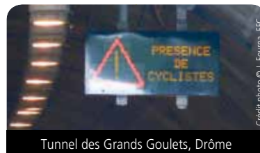
Tunnel des Grands Goulets, Drôme
