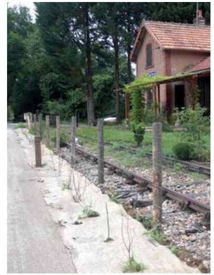
Vue de la voie verte qui va d'Alençon à Condé-sur-Huisne. © MN3V
