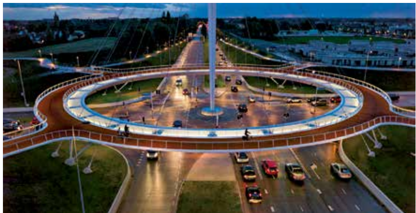
Ouvert en juin 2012, le rond-point suspendu d'Eindhoven est réservé aux cyclistes. © Chris Keulen
