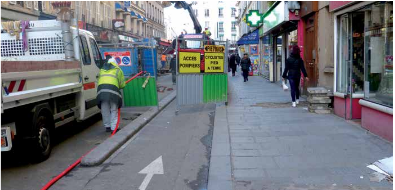
Interruption de la voirie pour travaux, un exemple de coupure temporaire.
