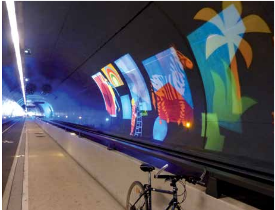
Le tunnel modes doux de la Croix-Rousse, à Lyon, permet aux cyclistes et aux piétons d'éviter un long détour.
