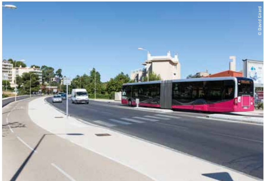
Des travaux annonçant la métropole de demain ? En allant vers Luminy, cette voirie requalifiée pour le passage du Bus à haut niveau de service (BHNS) intègre une piste cyclable à double sens.
